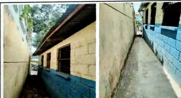
Foto 9: TRABAJOS EXTERIORES muro lateral derecho banquetas de concreto
