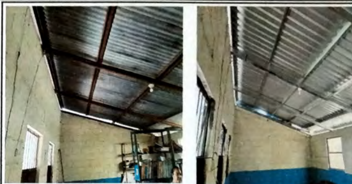
Foto 2: MODULO B cambio de estructura de metal por metal en mal estado y cambio de lamina de zinc por lamina troquelada cal 26.
