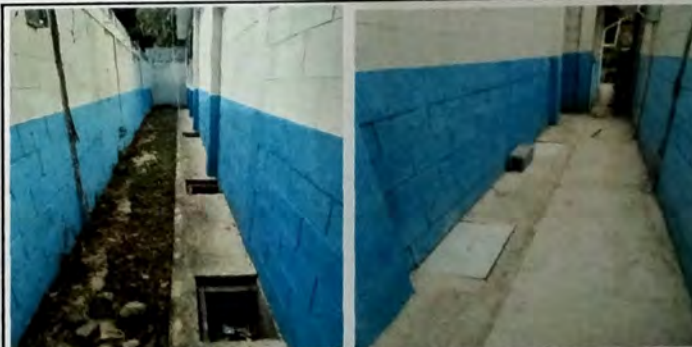
Foto 12: TRABAJOS EXTERIORES lado lateral izquierdo, fundicion de banqueta y fundicion de tapaderas de concreto en cajas de registro.
