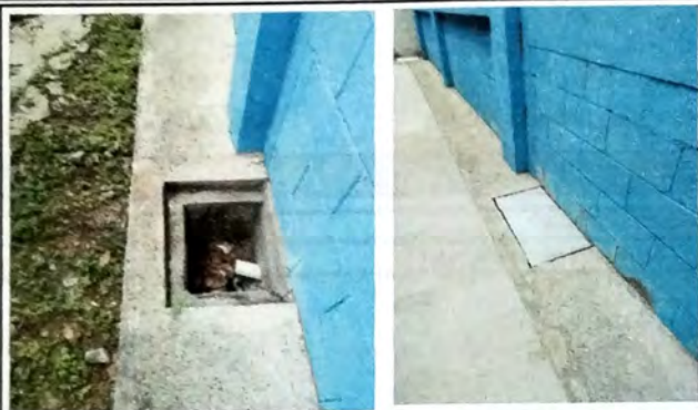
Foto 7: TRABAJOS EXTERIORES muro lateral izquierdo, fundicion de tapaderas de concreto y banquetas de concreto
