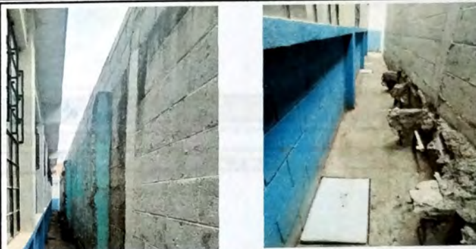
Foto 8: TRABAJOS EXTERIORES muro posterior fundicion de tapaderas de concreto y banquetas de concreto.
