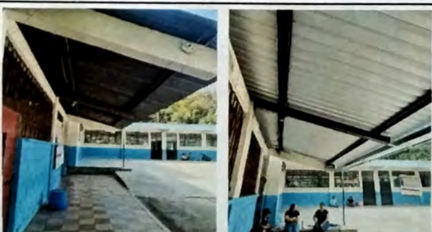
Foto 5: MODULO C Vista de Corredor, mantenimiento de estructura de metal por metal en mal estado y cambio de lamina de zinc por lamina troquelada cal 26.
