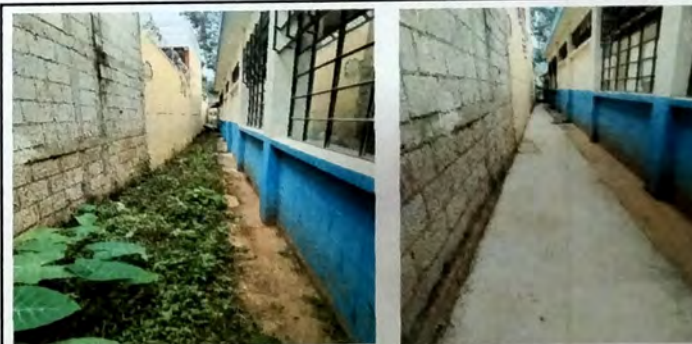
Foto 10: TRABAJOS EXTERIORES muro lateral derecho banquetas de concreto
