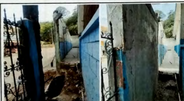
Foto 11: TRABAJOS EXTERIORES demolicion de segmento de muro que estaba desplomado en muro lateral izquierdo.
