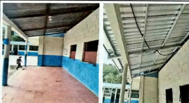
Foto 3: MODULO B VISTA DE CORREDOR cambio de estructura de metal por metal en mal estado y cambio de lamina de zinc por lamina troquelada cal 26.
